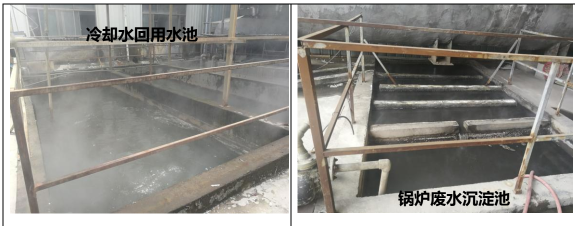
图 4-2 企业废水治理现场相关照片
