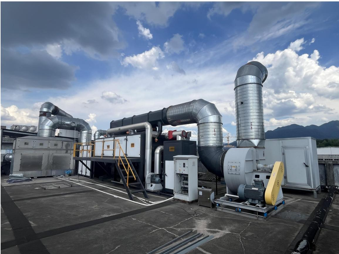
图 3-4 丝印、烘干、燃烧、喷漆废气处理设施现场图
