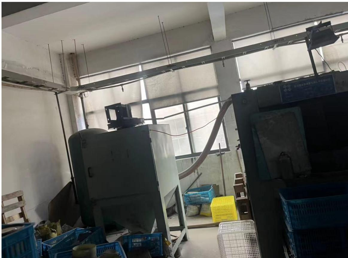
图 3-8 喷砂废气处理设施现场图
