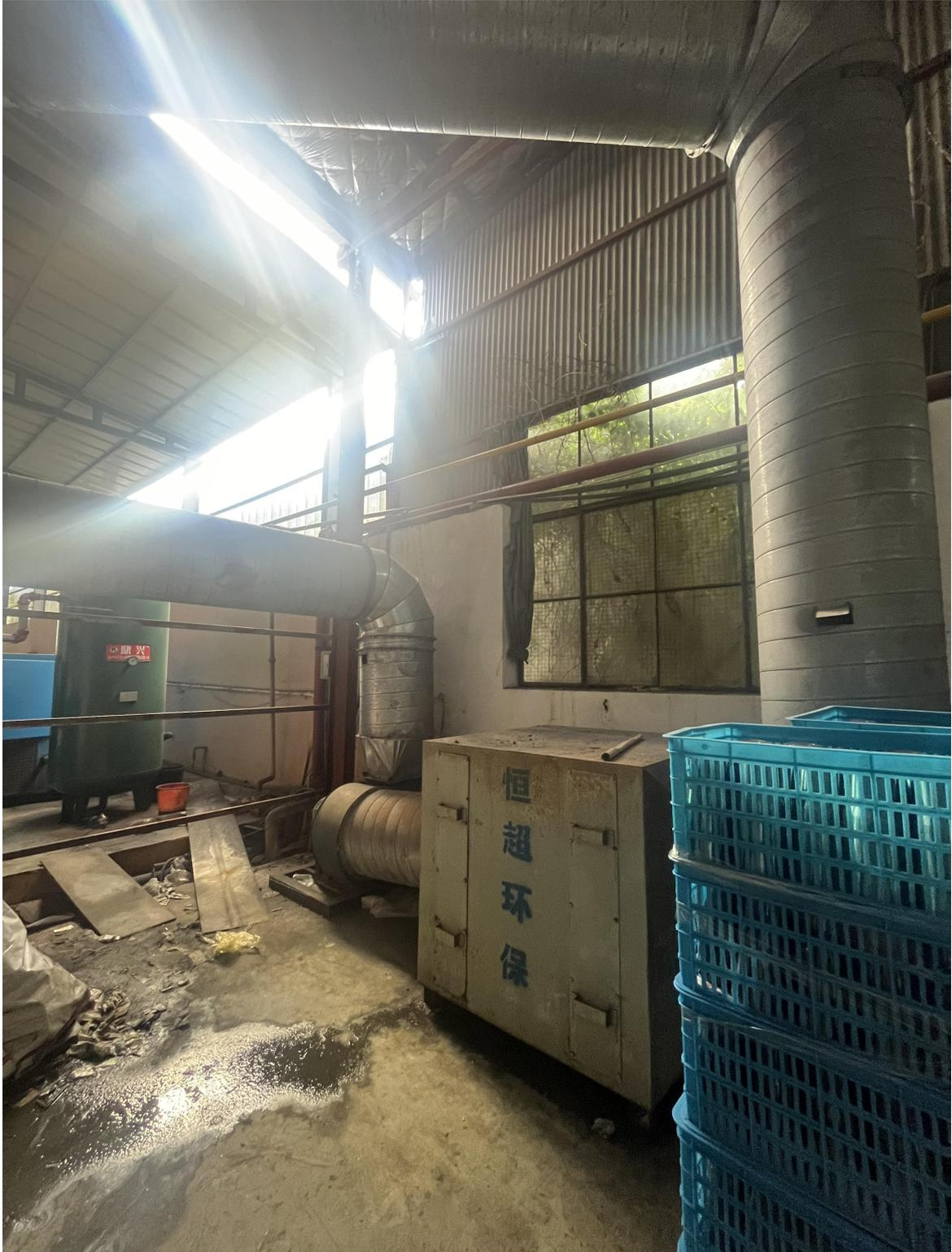
图 3-14 注塑废气处理设施现场图
