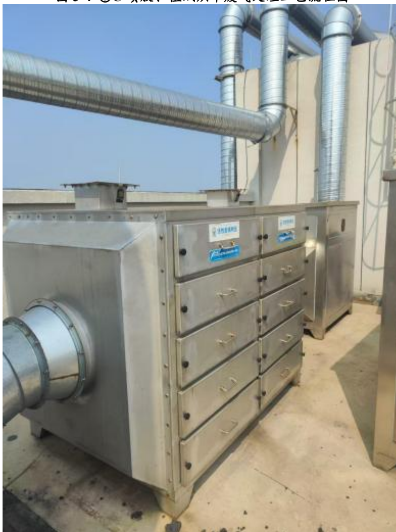
图 3-5 喷胶、植绒烘干废气处理设施现场图
