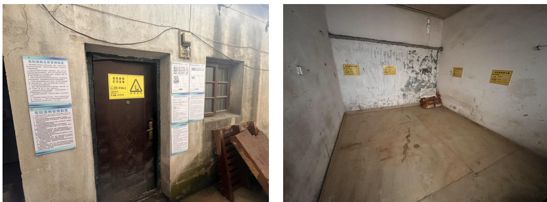
图 3-11 危废仓库现场图
