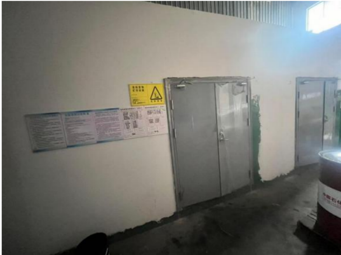
图 3-10 危废仓库现场图
