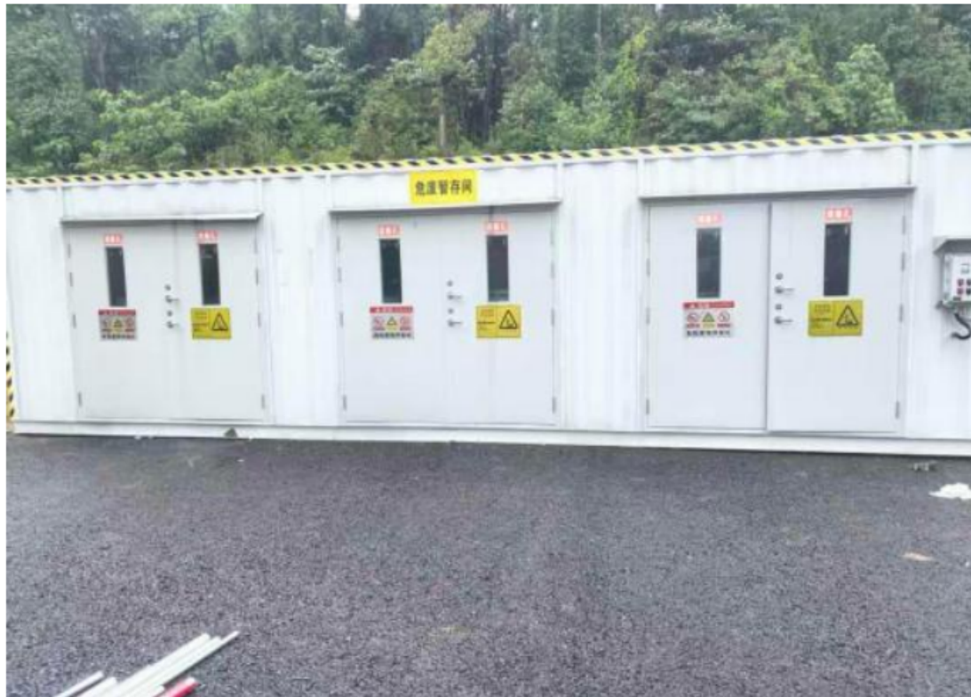
图 3-7 危废仓库现场图
