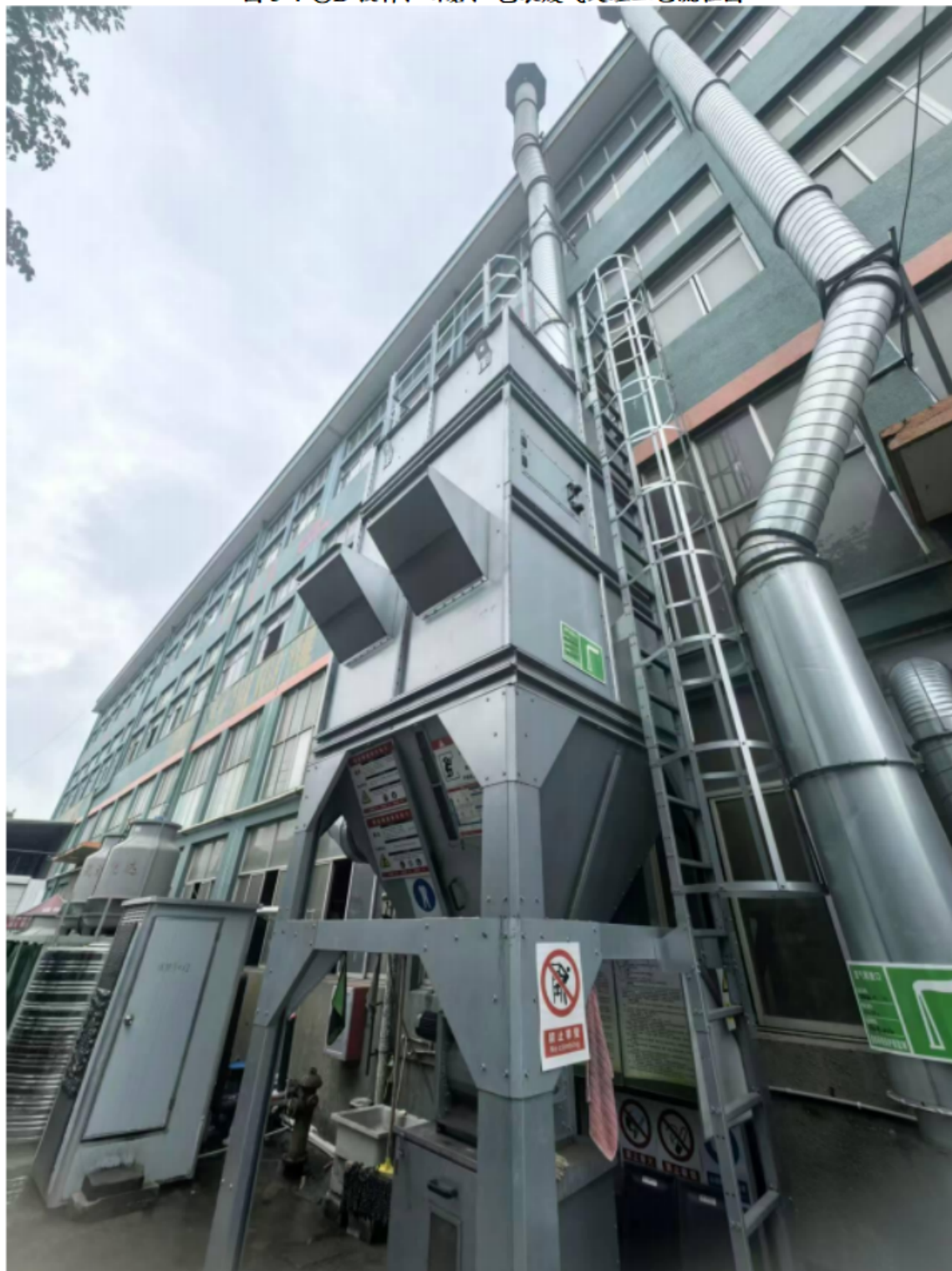
图 3-5 投料、研磨、包装废气处理设施现场图
