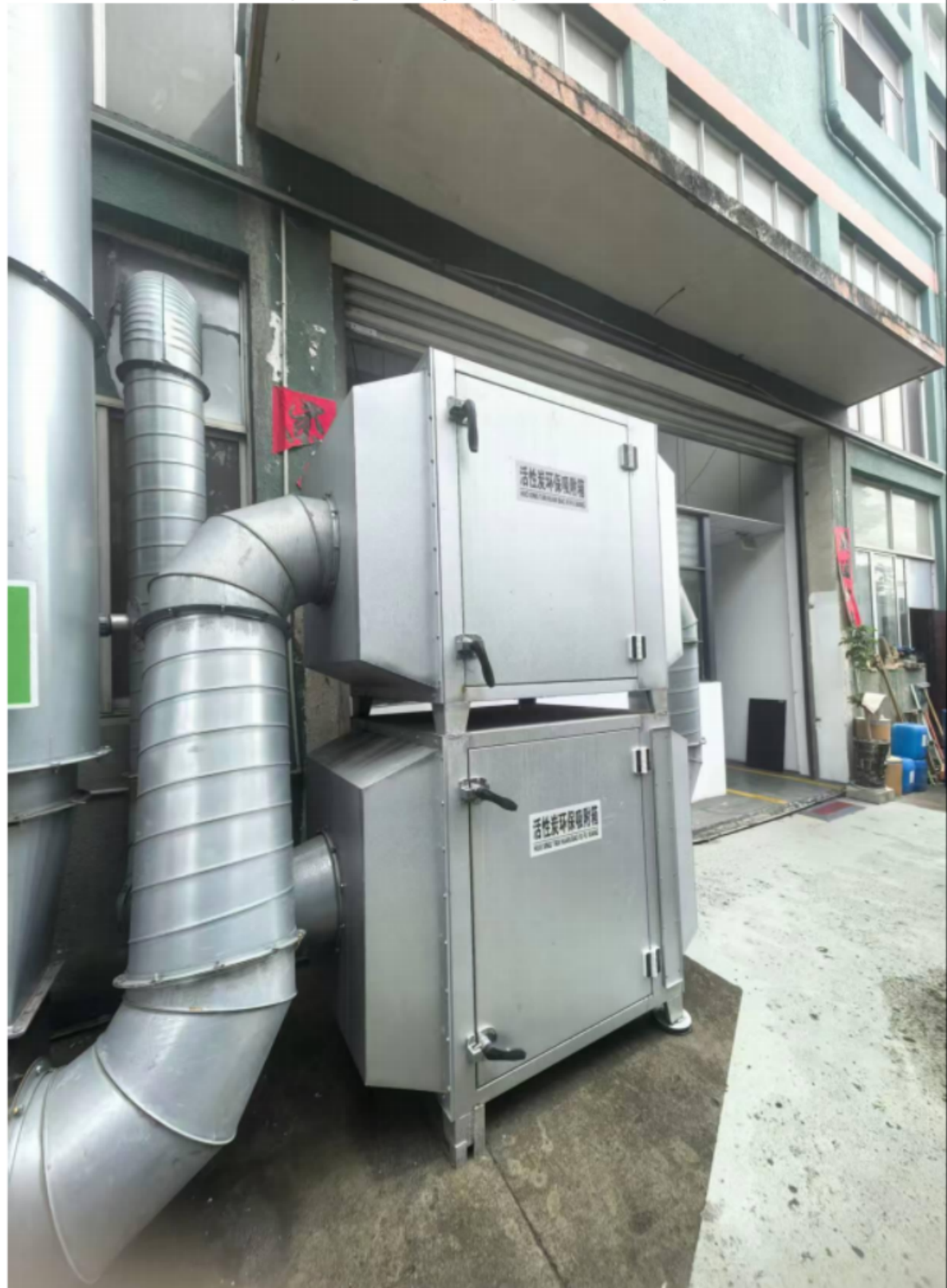
图 3-3 熔融挤出废气处理设施现场图
